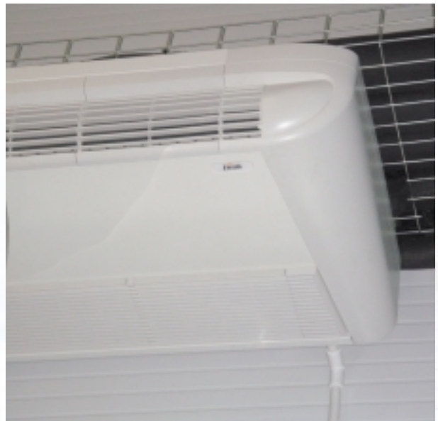
Multifunkční radiátor topí/klimatizuje
